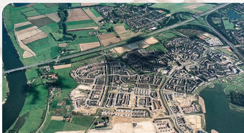
Maaspoort in aanbouw in 1990. Rechts boven knooppunt Empel met de Maaspoorthallen en de Abdijenbuurt.
